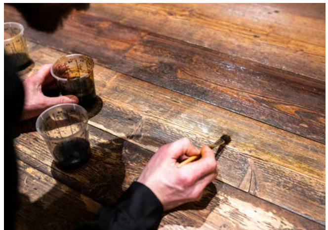
Die verschiedenfarbigen Beizen wurden in präziser Handarbeit mit dem Pinsel auf die abgenutzten Stellen aufgetragen.
