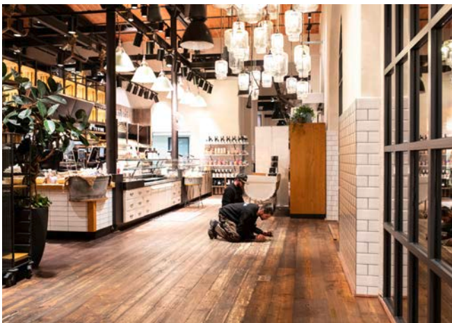
Mit der speziellen Technik wurde die 330 Quadratmeter große Parkettfläche des Cafés „Brothaus“ Abschnitt für Abschnitt über einen Zeitraum von 10 Tagen renoviert.
