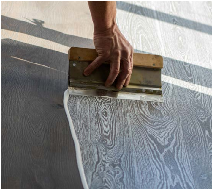
Durch den Auftrag der Farbspachtel PALL-X COLOR EFFECT setzen sich die Farbpigmente in den Vertiefungen des gebürsteten Bodens ab und erzielen den einmaligen Effekt, der den Dielenboden zum Unikat macht.
