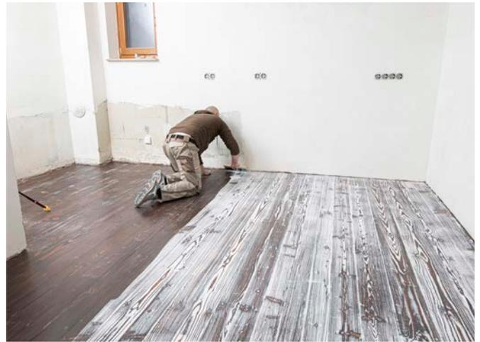
Mit einer Ölgrundierung in der Farbe dunkelbraun und mit der zweiten Farbschicht in der Farbe weiß wurde die natürliche Maserung des Holzes effektiv herausgearbeitet.
