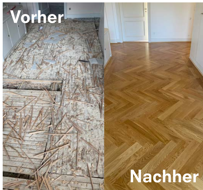
Die Herausforderungen bei diesem Bauvorhaben lagen insbesondere bei der aufwendigen Untergrundvorbereitung.
